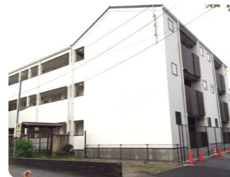
鳥取県米子市 集合住宅 A棟・B棟 【集合住宅】鉄骨造・3階建 建築面積(A棟)176㎡(B棟)185㎡
